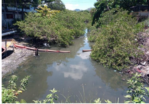
ECO 17 – CANAL DA VILA DO MARUÍ
