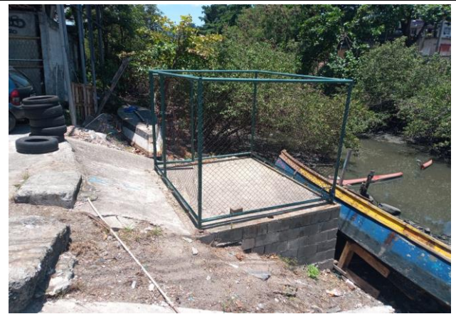
ECO 17 – CANAL DA VILA DO MARUÍ
