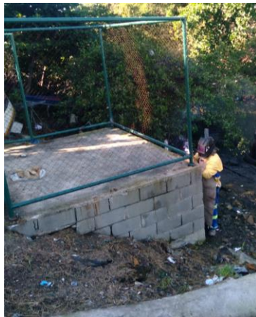
ECO 17 – CANAL DA VILA DO MARUÍ
