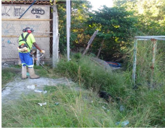
ECO 17 – CANAL DA VILA DO MARUÍ
