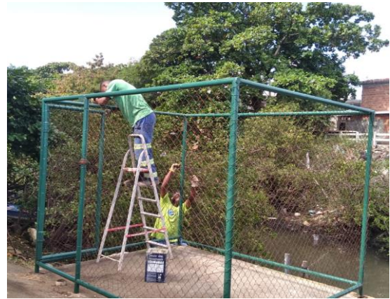
ECO 17 – CANAL DA VILA DO MARUÍ
