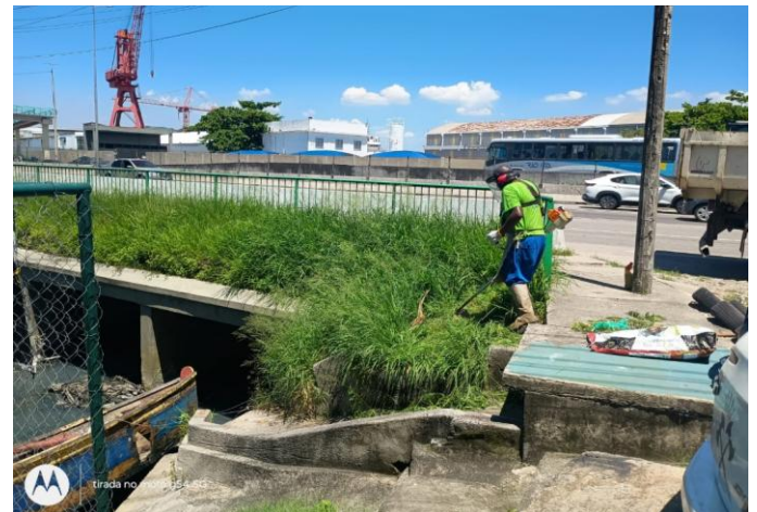
ECO 17 – CANAL DA VILA MARUÍ
