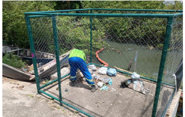
ECO 17 – CANAL DA VILA MARUÍ
