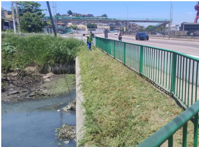
ECO 17 – CANAL DA VILA MARUÍ
