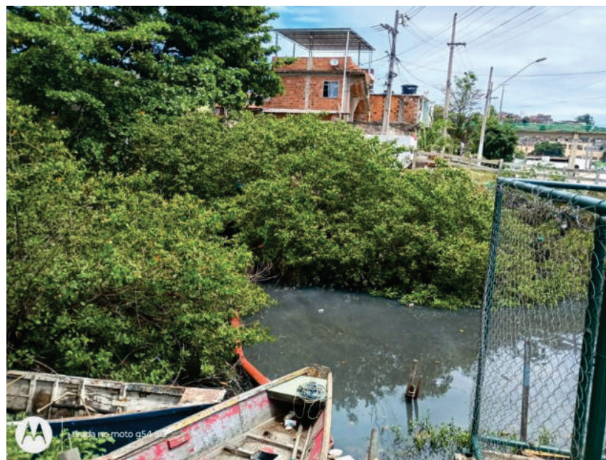
ECO 17 – CANAL DA VILA MARUÍ
