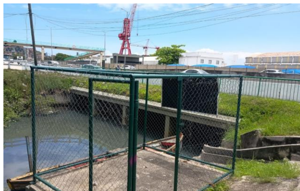
ECO 17 – CANAL DA VILA MARUÍ
