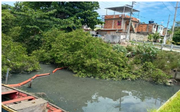
ECO 17 – CANAL DA VILA MARUÍ
