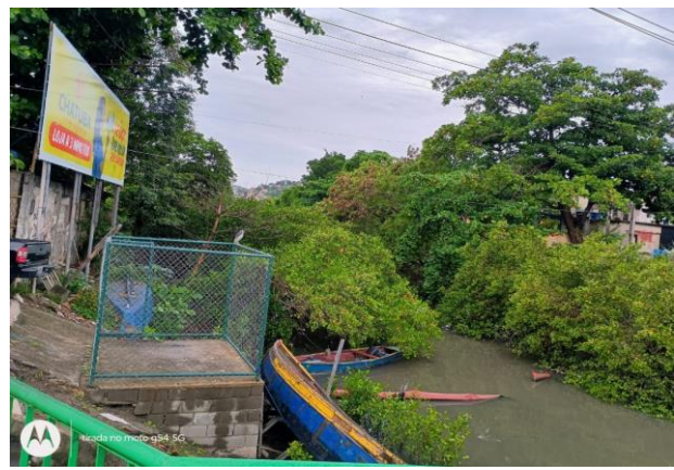
ECO 17 – CANAL DA VILA DO MARUÍ
